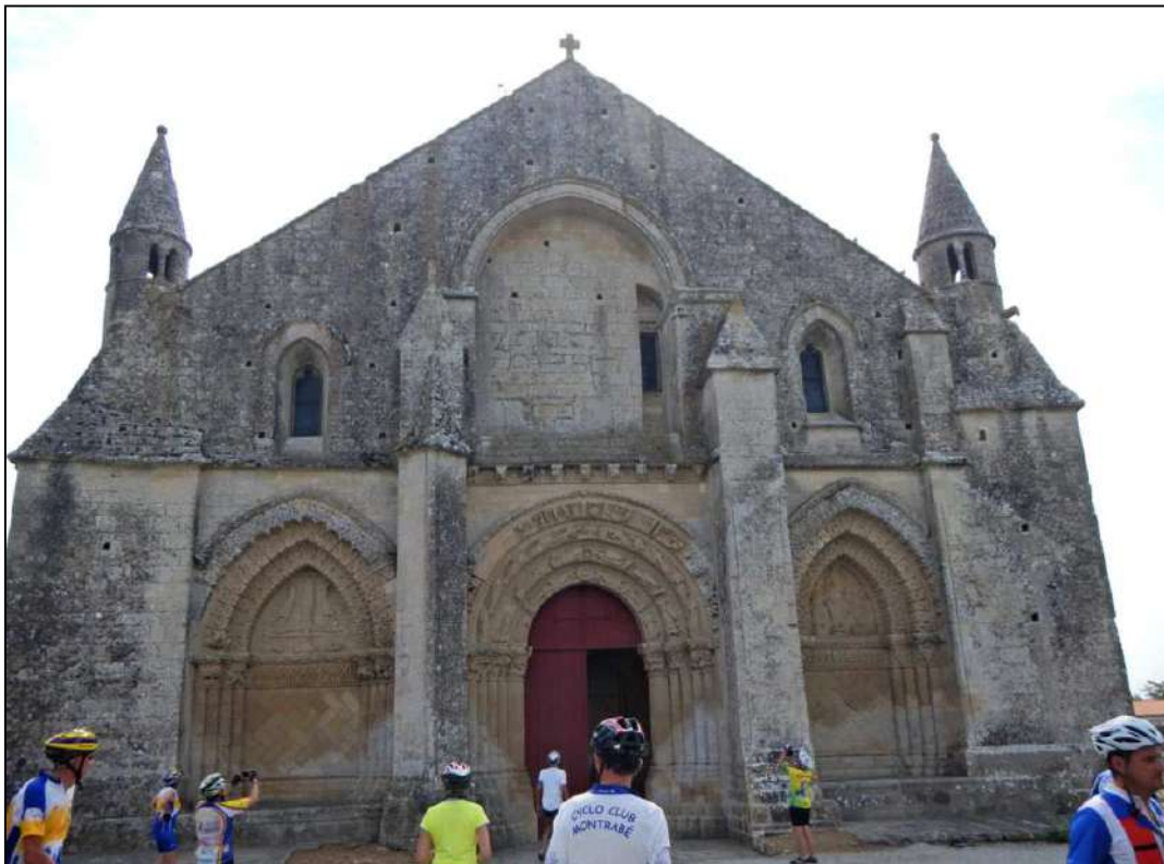
Façade de l'église St-Pierre d'Aulnay © M. Lavalou.
